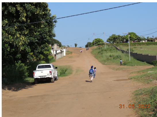
Figura 3-11: Vista da linha de baixa tensão no lado direito da estrada
