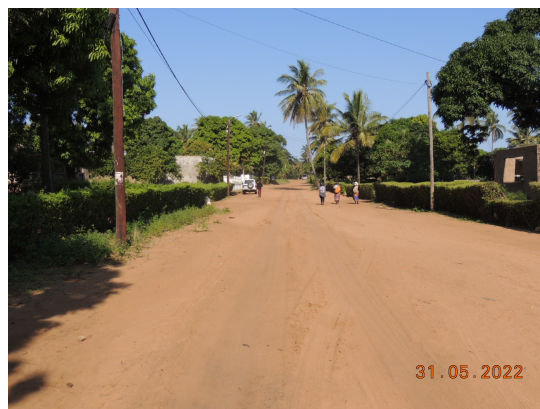
Figura 3-12: Vista de postes de linha de telecomunicações do lado direito e da linha de baixa tensão do lado esquerdo
